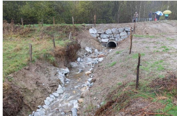
Figure 15 : Remplacement d'ouvrage de voirie pour le rétablissement de la continuité écologique (Source : HCC)
