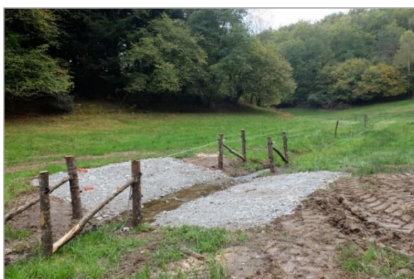
Figure 7 : Passage à gué (Source HCC)
